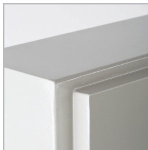
Полностью проваренные швы.
