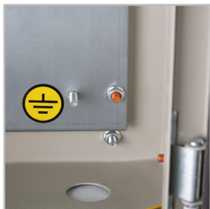
Шпилька заземления на монтажной панели.
