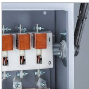
Устройство запирания дверцы.
